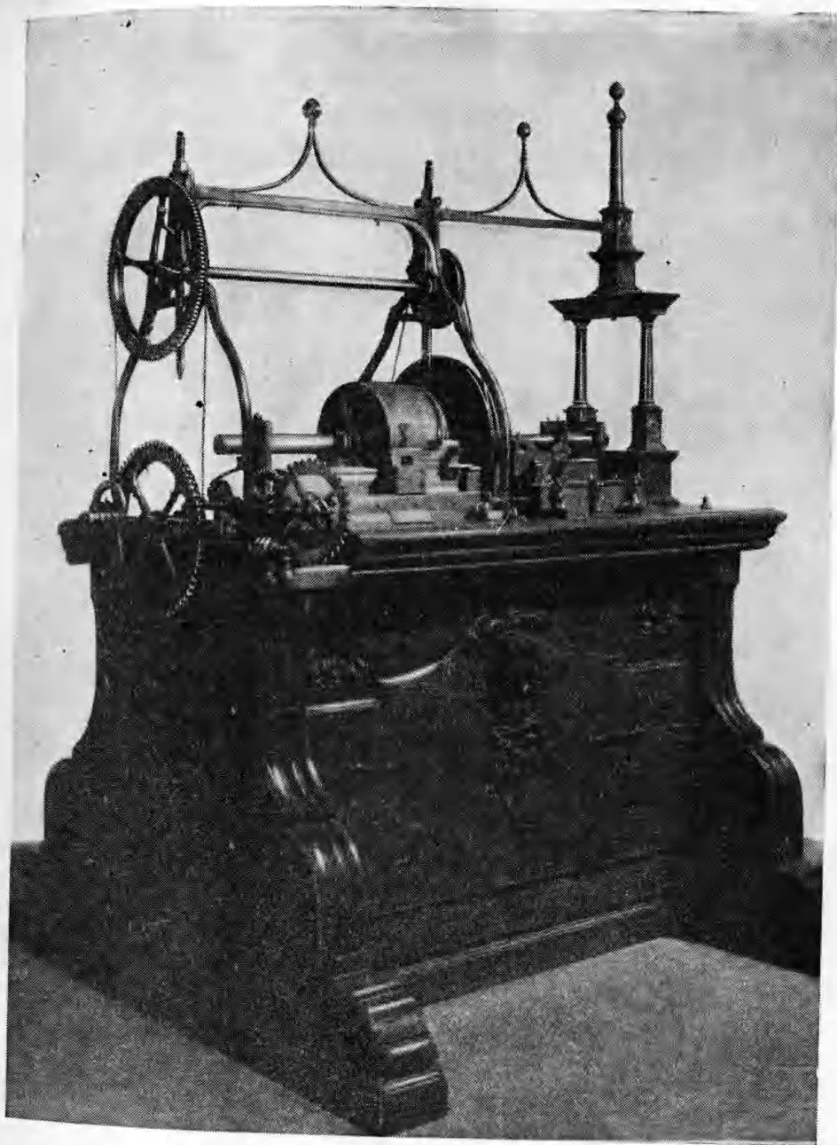
Фиг. 26. Большой токарно-копировальный станок Нартова 1718—1729 гг.
