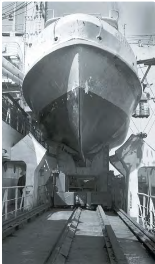
Тележка везет РДС для установки на кильблоки
