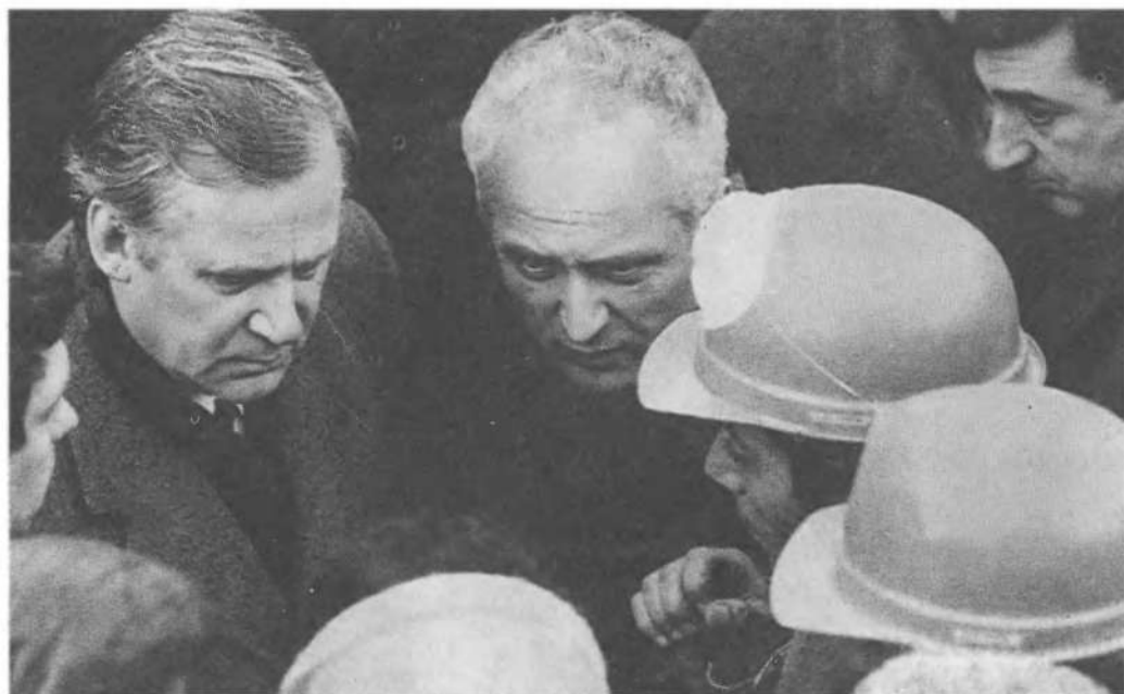
На улицах разрушенного Спитака. Декабрь, 1988 г.
